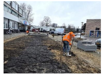
Werkzaamheden Berflop plein
